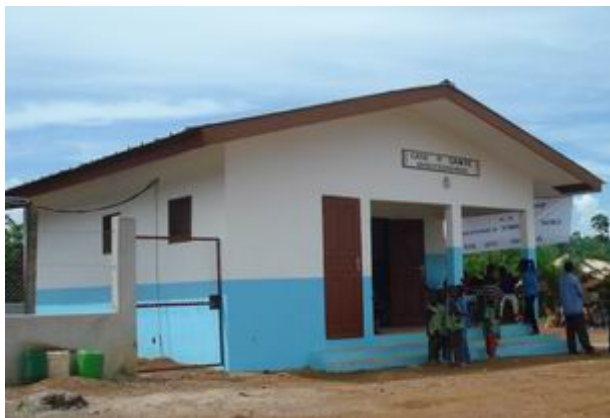
A Diakité Dougou (al confine con il Ghana), il 7 maggio 2008, è stata inaugurata la prima "Antenna": un piccolo dispensario ( Case de Santé ), alimentato da pannelli solari fotovoltaici.
