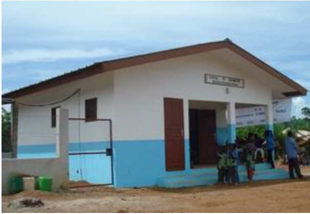
Le 7 Mai 2008 à Diakité Dougou (près du Ghana), a été inaugurée la première "antenne" de l'Hôpital Général d'Ayamé: une Case de Santé, branchée a des panneaux solaires photovoltaïques.
